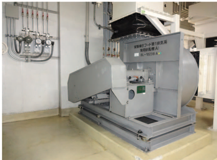
図 2.10.2-2 実験棟 B フード第 1 排気系統の 排風機 A 号機及び接点付差圧計（交換後）
