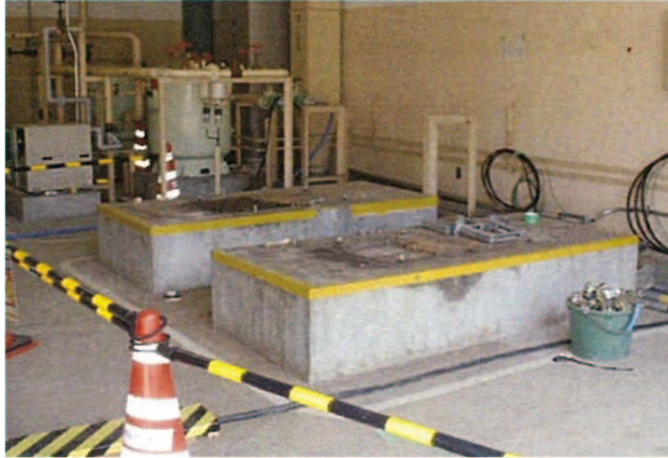
写真 2.1.11-1 既設空気圧縮機撤去後
