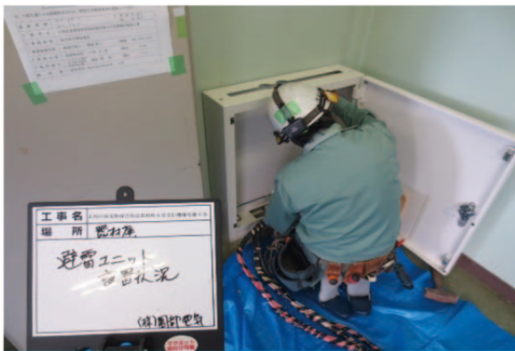
写真 2.10.8-1 避雷ユニット設置状況
