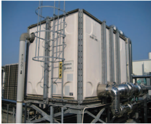
写真 2.1.10-1 冷水槽上部手摺設置前
