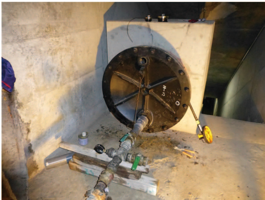
写真 2.10.9-1 久慈川導水管エアミルク充填状況（常磐自動車道横断部）
