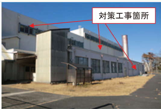
写真2.10.7-1 施設全景（施工前）
