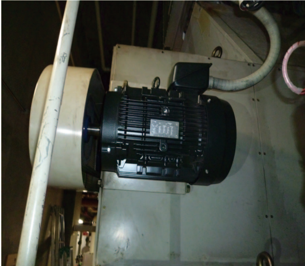
写真 2.1.13-1 電動機更新
