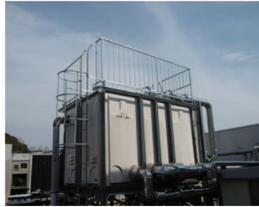
写真 2.1.10-2 冷水槽上部手摺設置後
