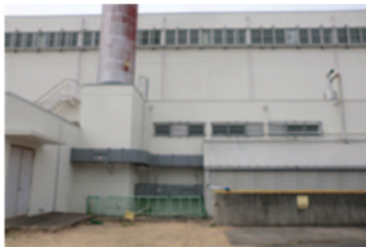
写真2.10.7-4 ホットラボ 外壁防水 補修後
