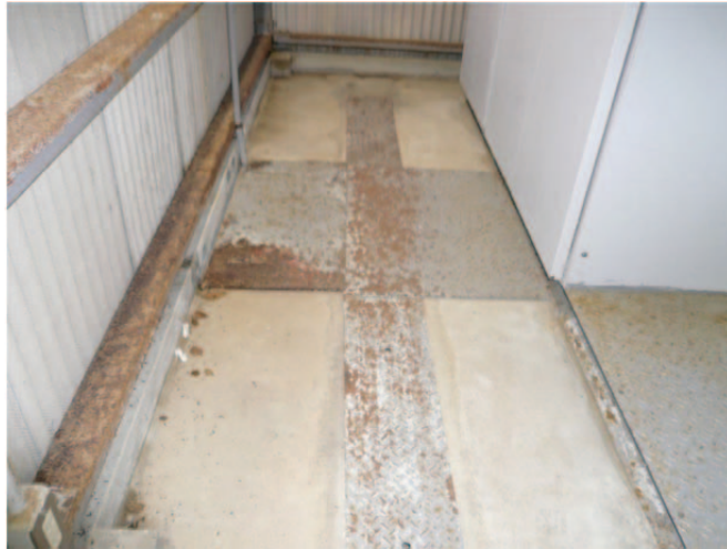
写真 2.1.3-1 電気室内塗装前
