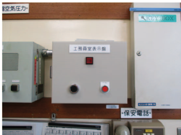
写真 2.10.3-1 居室に設置した表示盤
