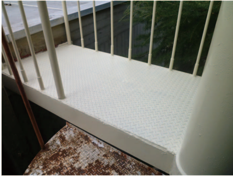
写真 2.1.14-1 螺旋階段天板補修
