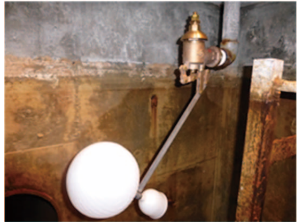
写真 2.10.4-2 交換後のボールタップ
