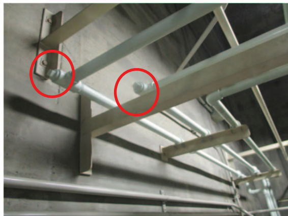
写真 2.1.7-2 更新した冷却水配管(丸部は止栓取り付け部(4箇所))
