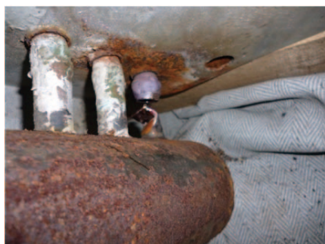
写真 2.1.6-3 コイル補修前
