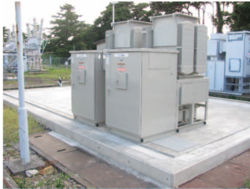
写真 2.1.19-1 更新した進相コンデンサ（K26、K27）
