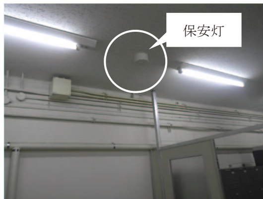
写真 2.1.17-1 更新した保安灯
