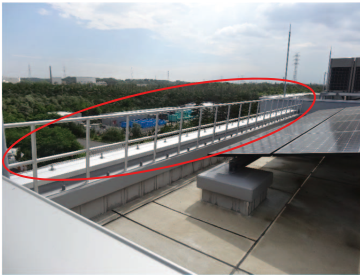
写真 2.1.21-1 J-PARC 研究棟屋上手摺り
