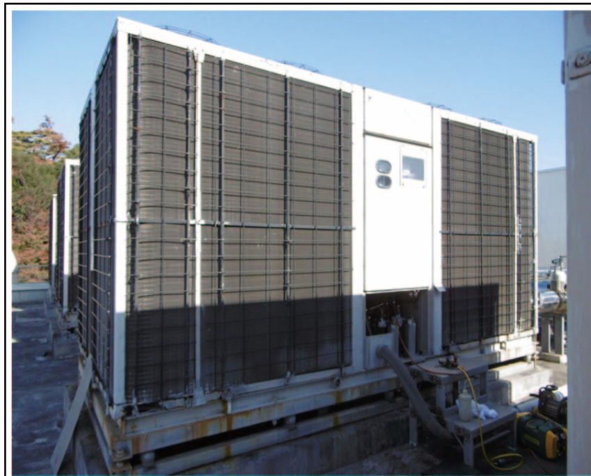
写真 2.7.1-1 ウォーターチリングユニット外観
