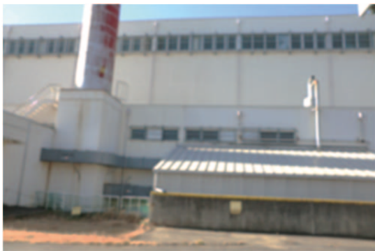
写真2.10.7-3 ホットラボ 外壁防水 補修前
