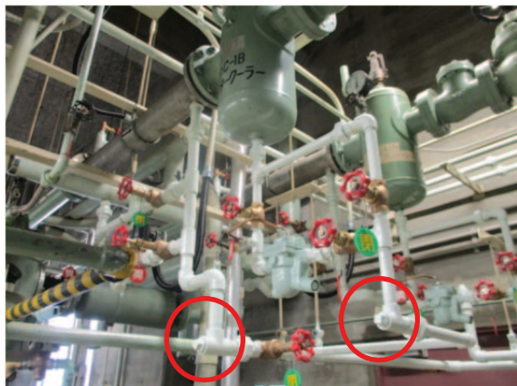
写真 2.1.7-2 更新した冷却水配管(丸部は止栓取り付け部(4箇所))
