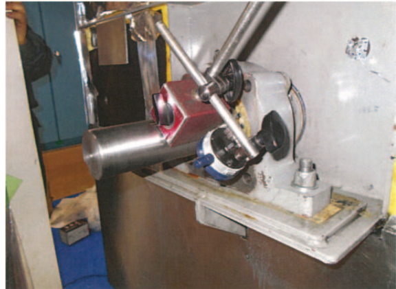
写真 2.1.5-2 新品シャフトの芯出し作業
